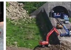
令和3年6月 乙部町土砂崩壊 24時間作業で無人バックホーにより 崩落土砂を除去
