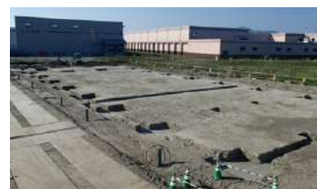
●TNF工法 基礎と地盤改良の一体化により、杭を必要とせず安全でローコストな基礎工事
