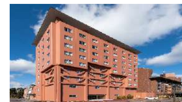
●ピタコラム工法 耐震補強工法による既存建物の長寿命化
