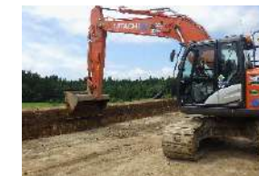
●i-Construction ICT土工で安全かつ効率的な施工
