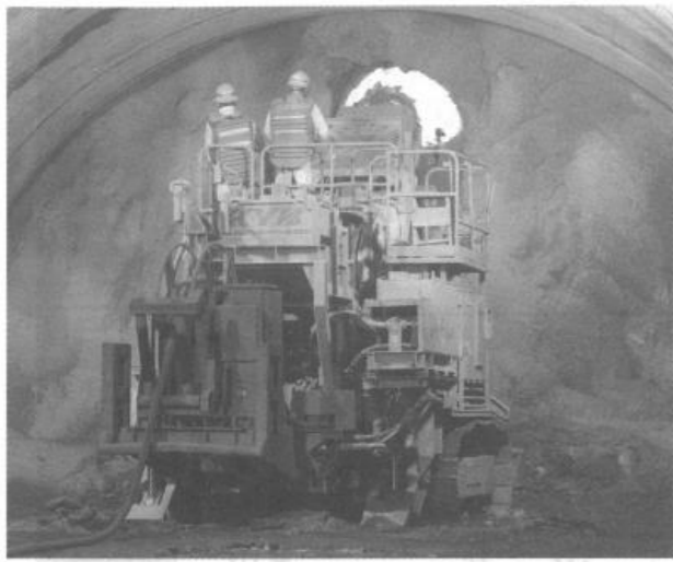
ブームヘッダーが最後の岩盤を貫き、一筋の光が差し込んだ
